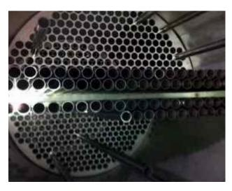
Le liquide produit est généralement chauffé a base température pour chaque passage à travers de l'échangeur de chaleur. Pour maintenir un bon transfert dans celui-ci, il est nécessaire d'avoir une haute valeur dans le flux de recirculation.
